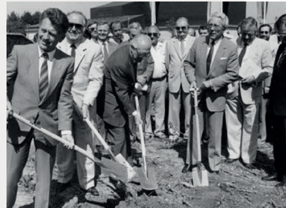
1984: Începutul primei faze de construcție la Neuenheimer Feld în Heidelberg.
