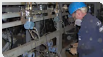
Măsurare debit injecție abur intermediar și apă alimentare intrare cazan
